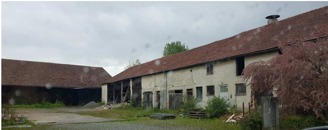
Abb. 5: Blick von der Durchgangsstraße in Richtung Hofstelle mit den ungenutzten landwirtschaftlichen Gebäuden Quelle: mks Architekten-Ingenieure GmbH
